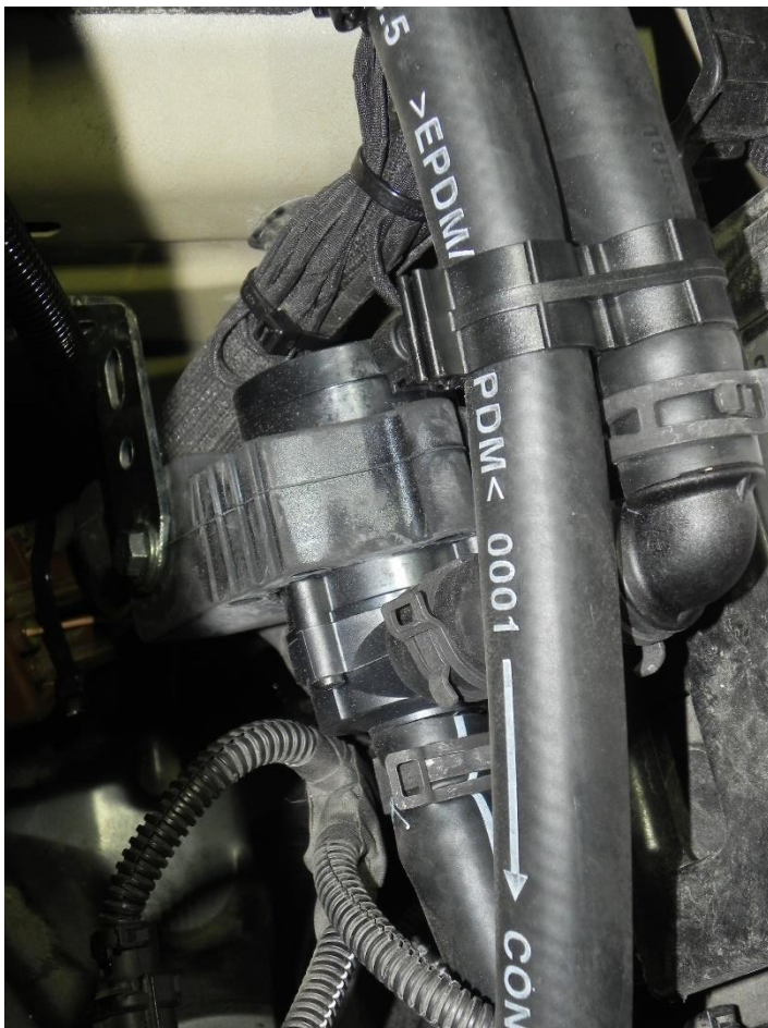
pompa obiegowa wody
